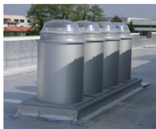
Chimenea cilíndrica y zócalo redondo con borde de sombrero (Escuela de Massalengo 2009)
