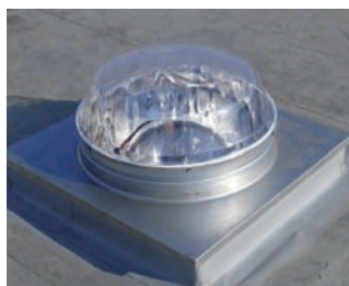
Zócalo cuadrado instalado en el soporte (Tesco 2009)
